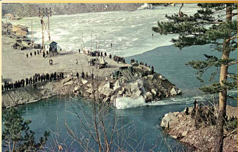
25 марта 1963 год. Перекрытие русла реки Енисей
