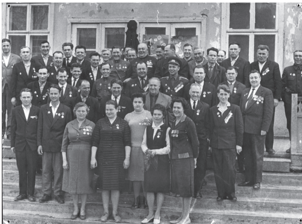
Более трёх тысяч фронтовиков участвовали в строительстве Красноярской ГЭС
